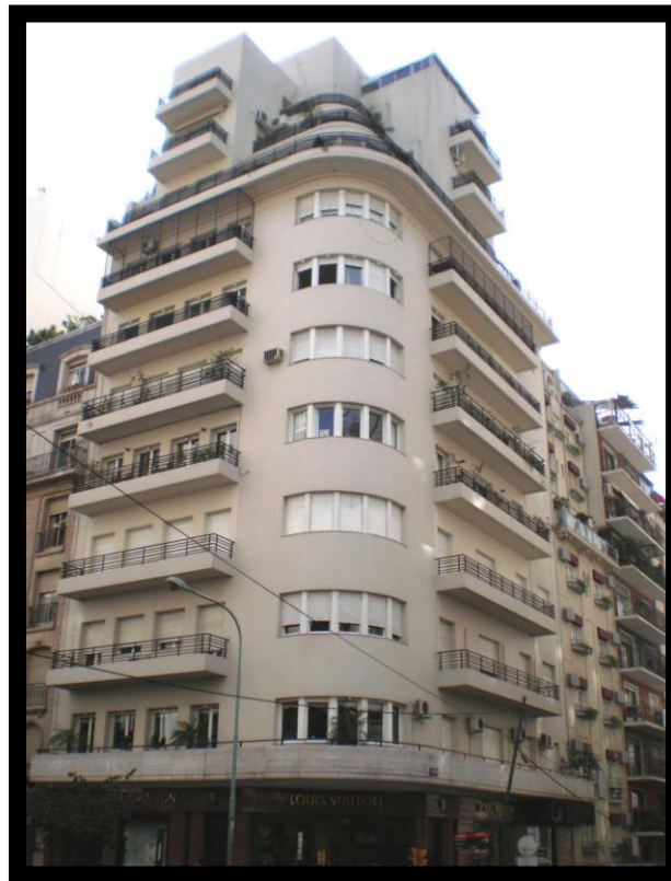
Edificio Calle Alvear esq. Ayacucho – Capital Federal
