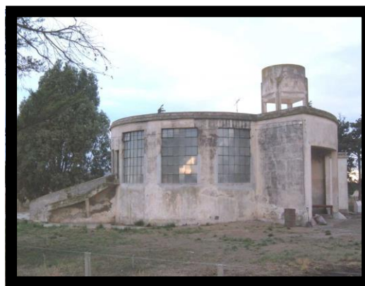
Ex Matadero Municipal de Saldungaray - Tornquist
